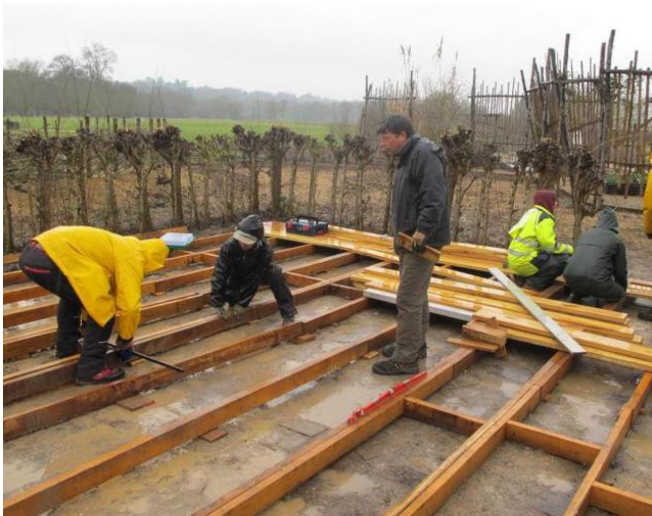
Les stagiaires en train de mettre en place la terrasse en bois. - dr
